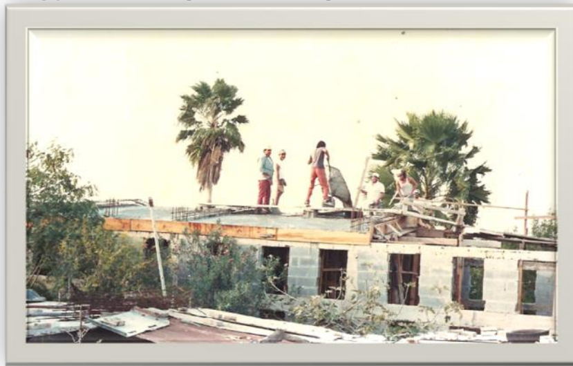
Vaciando la primera parte de la placa del templo (1986).
