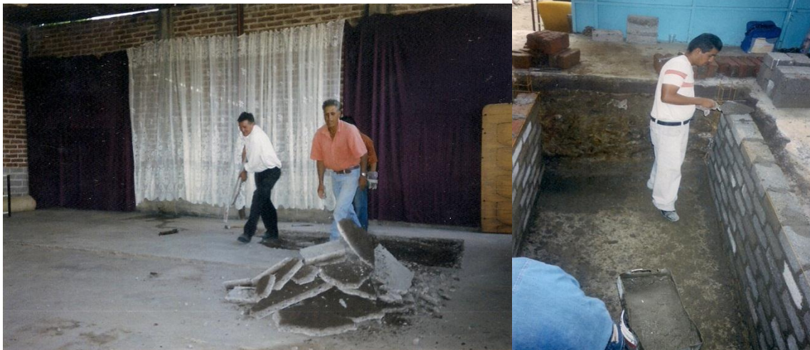
Se construye pila bautismal
