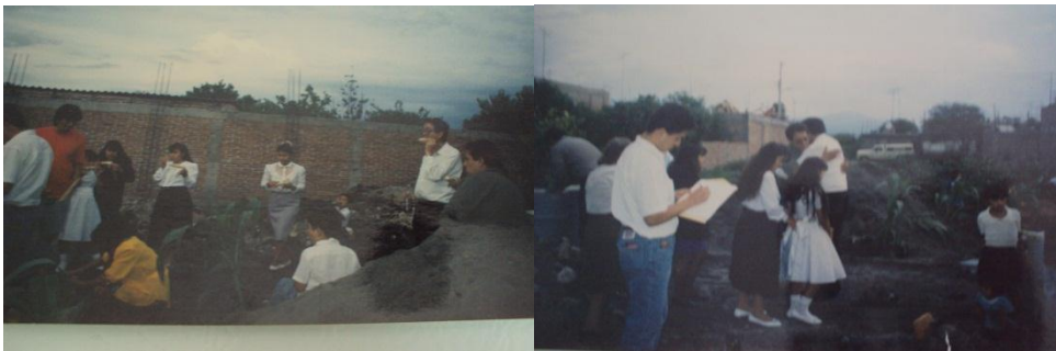
Fotos en donde se aprecia al hno. Humberto Anguiano y a su hijo David Anguiano, en el momento que se pone la primer piedra para dar inicio la construcción. Año de 1993.
