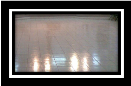
Se coloca el vitropiso en ambas plantas
