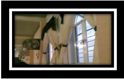
Se coloca toda la herrería ventanas y ventanal
