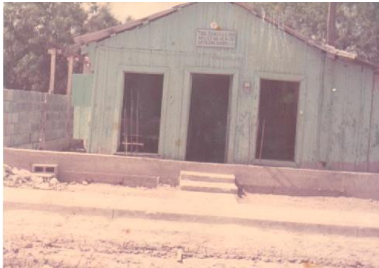
El templo de madera de la Tercera Iglesia y la cimentación de lo que sería el nuevo templo, proyecto iniciado por el hermano Eliceo Gaytán.
